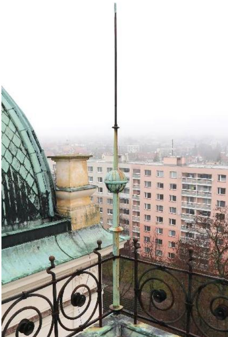
Obr. č. 9: Detailní pohled na nárožní sloupek – původní stav. Ocelový sloupek, který přechází v hrotnici je částečně opláštěn měděným plechem. Na hrotnici je umístěná makovice sletovaná ze segmentů. Pod makovicí se nachází ozdobný prstýnek. Spojení měděných prvků jsou provedeny zaletováním cínem.
