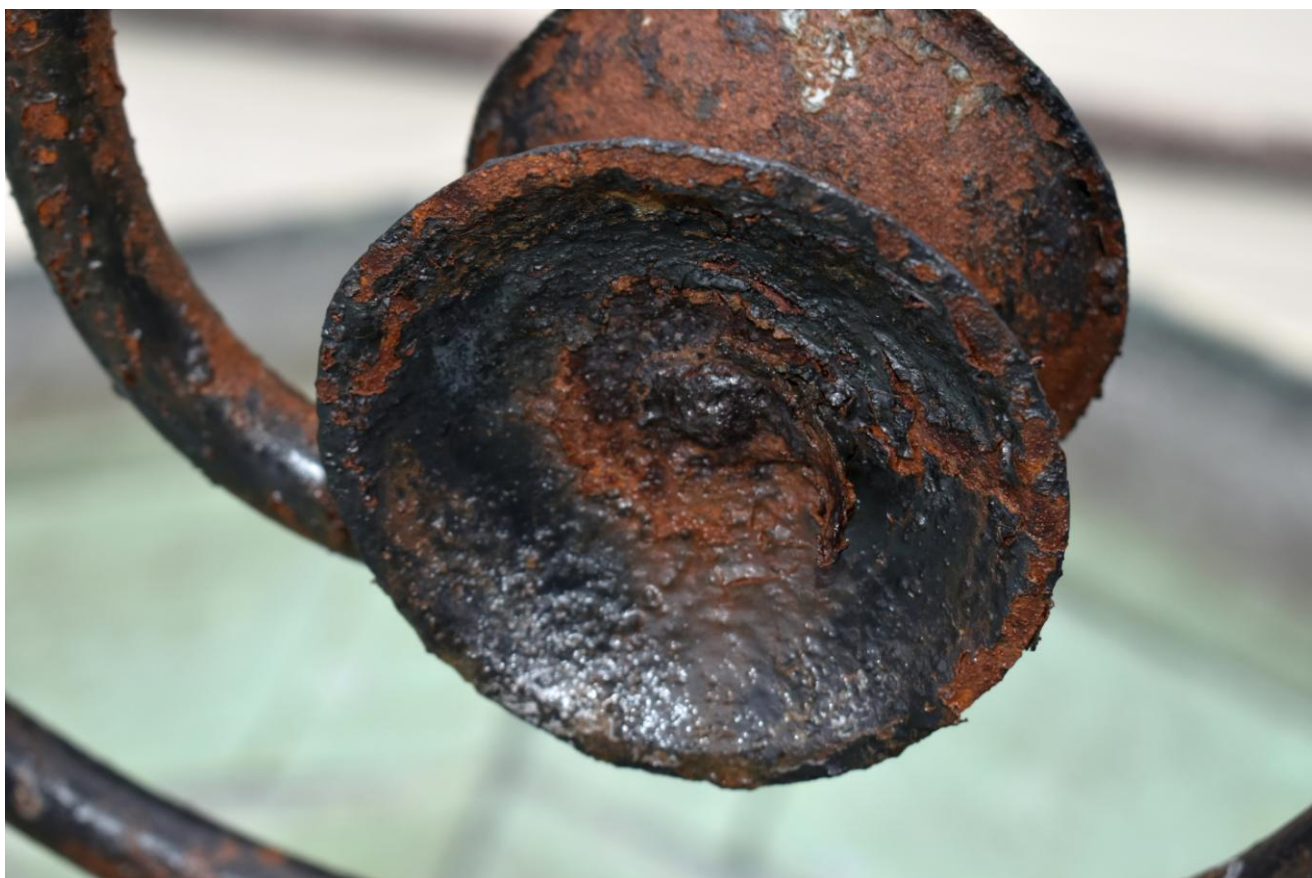
Obr. č. 18 + 19: Detailní pohled na poškozená místa – původní stav. Na některých místech zcela chybí plechové květy.
