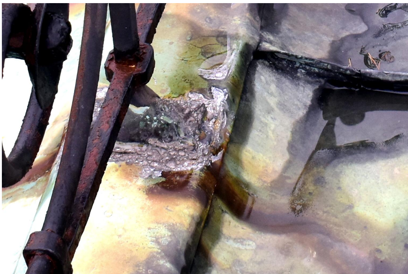
Obr. č. 10 - 12: Detailní pohled na vzpěru zábradlí a kotvení sloupku – původní stav. Ze snímku je patrné poškození oplechování kolem patky vzpěry. Stav ocelových částí sloupků a vzpěr pod oplechováním bude zjištěn až po rozkrytí oplechování. Při montáži je nutné pečlivě zabránit styku Fe a Cu a vyloučit vzniku makročlánku.
