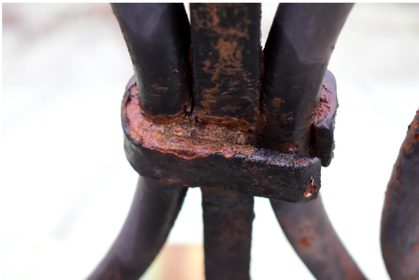
Obr. č. 13 + 15: Detailní pohled na mechanicky poškozené spony – původní stav. Vlivem působení korozních produktů jsou spony mechanicky poškozené a neplní svůj účel.
