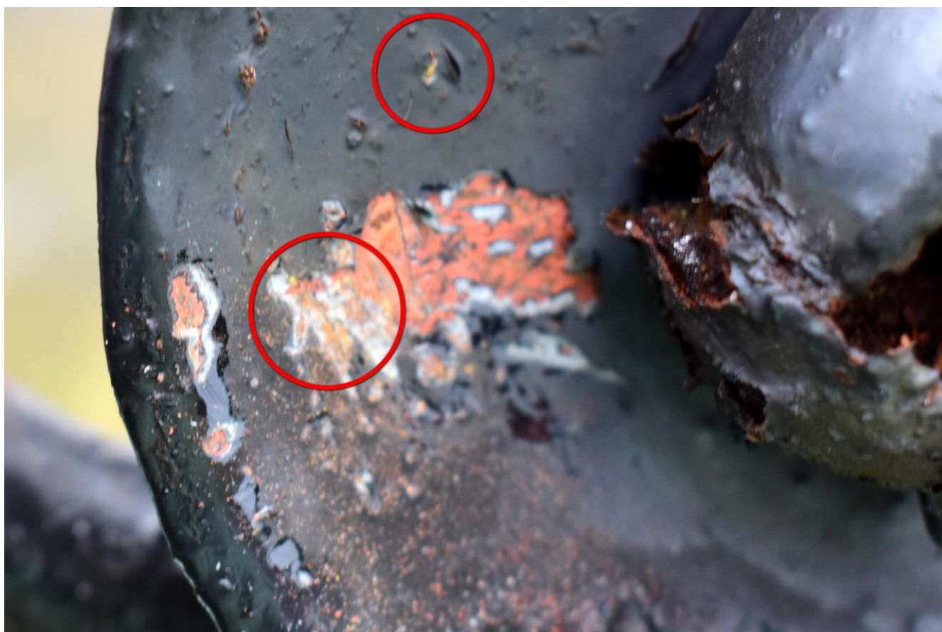
Obr. č. 20 + 21: Průzkum barevných vrstev na místě nebyl průkazný. Bylo objeveno několik barevných vrstev různých odstínů. Na plechové misce byly objeveny fragmenty barevné vrstvy ve žlutém odstínu (označeno na spodním snímku). Mohlo by se jednat o podkladovou vrstvu pod pozlacení.
